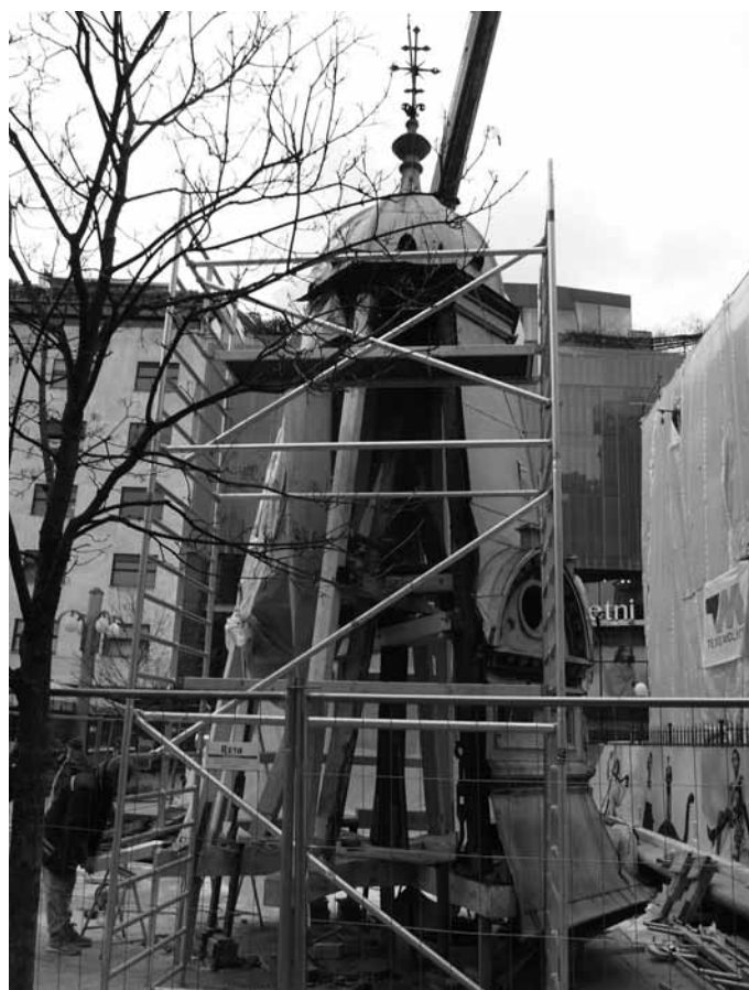
Skidanje bakrenog limenog pokrova s kupole Preobraženjskog hrama, 26. 2. 2023. / fotografija: D. Damjanović
