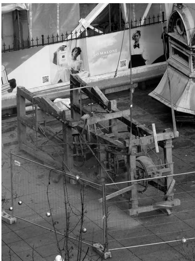
Konstrukcija za zvona Preobraženjskog hrama nakon skidanja s tornja 13. 1. 2023. / fotografija: D. Damjanović
